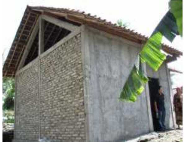
ジャワ地震支援事業で再建されている住宅
