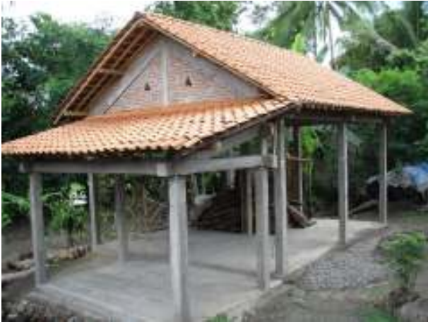
ジャワ地震支援事業で再建されている住宅
