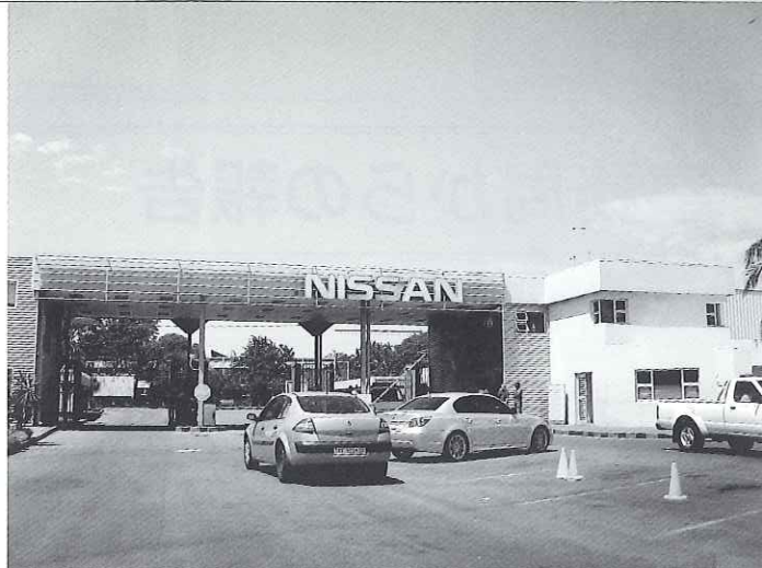
首都プレトリア近郊の産業地区にある Nissan South Africa(PTY)Ltd の建物
