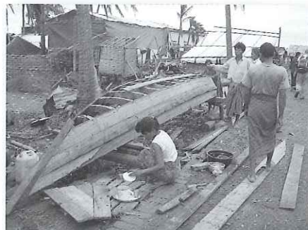
サイクロンで破損した船を修復する村人たち。被災地では被害を受けた船が多く見られた。大小の川が張り巡らされた地形のイラワジ・デルタ地区では、船は重要な交通手段
