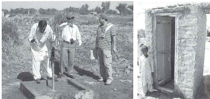
村に設置されたハンドポンプ式の井戸(左)とトイレ(右)
