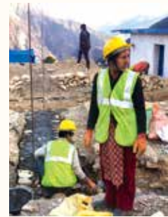
▲現場の女性建設作業員
