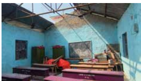
暴風で屋根が吹き飛ばされた教室
