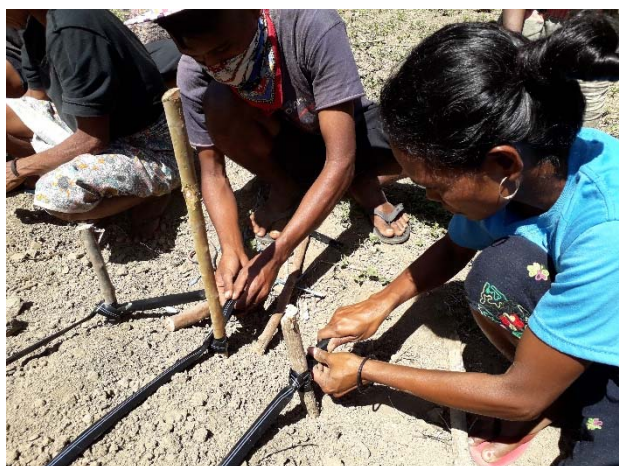
点滴灌漑設備敷設の現地研修
